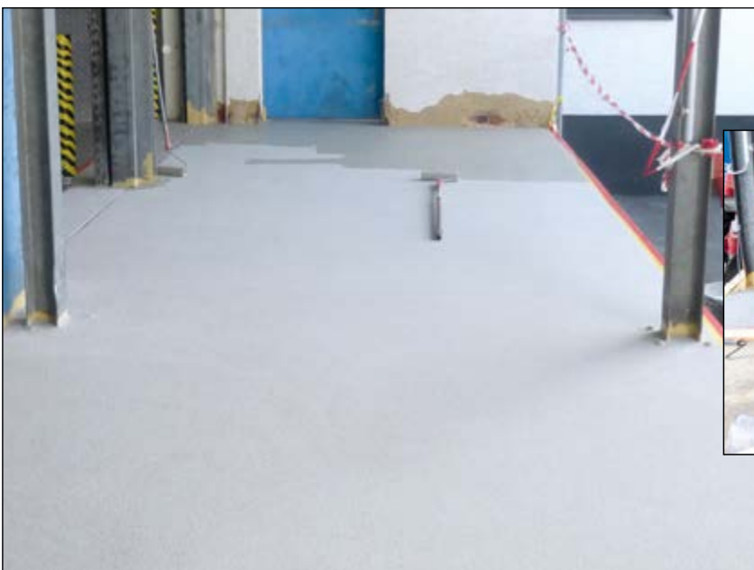
Left: Fahrzeugwerke Faymonville AG, Billingen/Belgium: Repairing expansion joints
