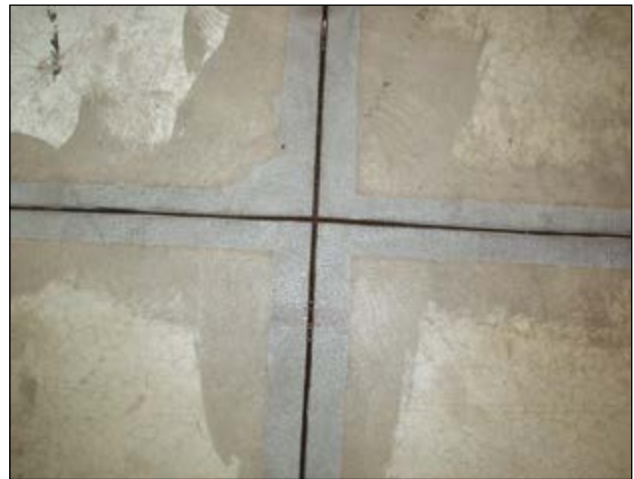
May Werke GmbH & Co. KG, Erfstadt-Köttingen/Germany: Renovation of expansion joints
